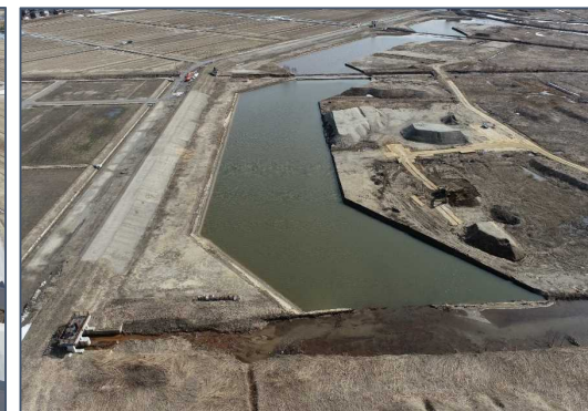
完成写真〔③工区〕
