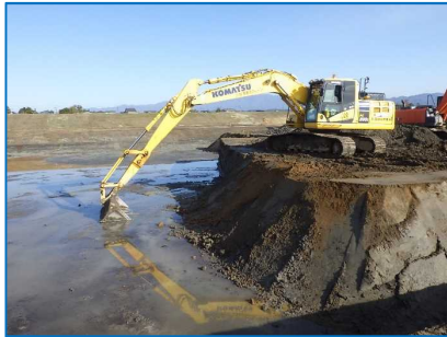
ICT土工（平場掘削）施工状況
