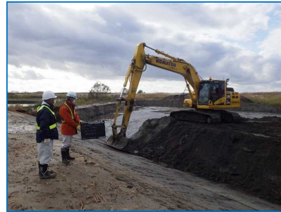
ICT土工（法面整形）施工状況
