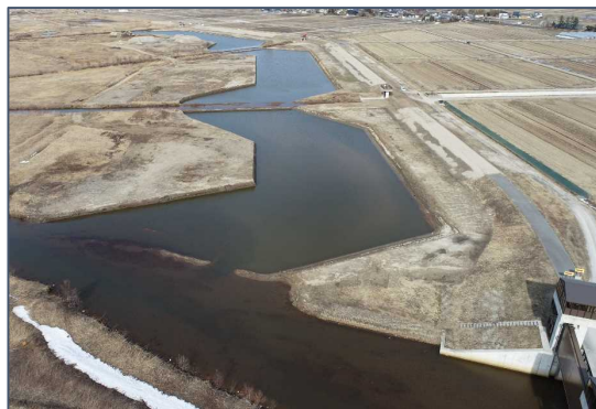
完成写真〔①工区〕
