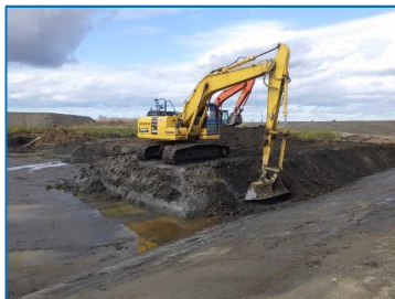
〔法面整形〕 丁張不要で施工
